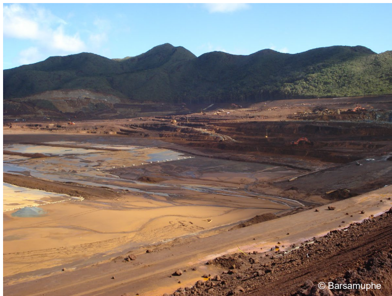
Construction du stockage de résidus de la mine de Goro, Nouvelle Calédonie, France
