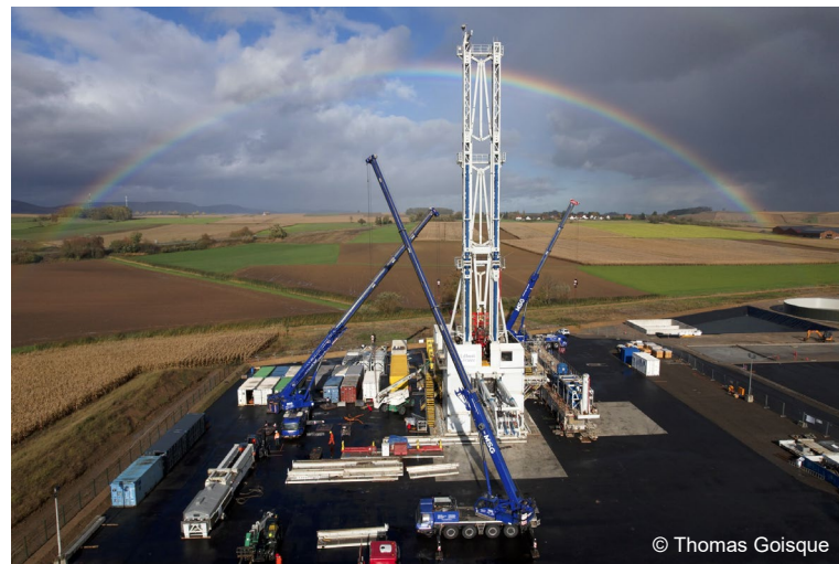
Forage géothermique, projet Lithium de France, Schwabiller (Alsace), Arverne Group
